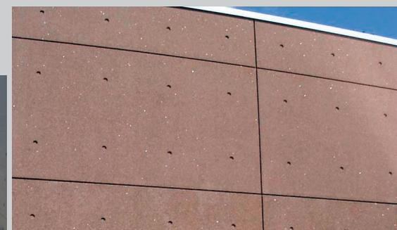
Beim Schalen und Betonieren von Wänden unter Verwendung von wiederverwendbaren Schalungsankern entstehen zwangsläufig konische Aussparungen im Beton. Diese Öffnungen können mit FRANK-Sichtbetonkonen aus Faserbeton nicht nur technisch einwandfrei verschlossen werden, sondern als gestalterisches Element die Architektur unterstreichen.
