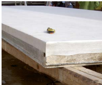
Zemdrain® MD selbstklebend auf der Schalung montiert
