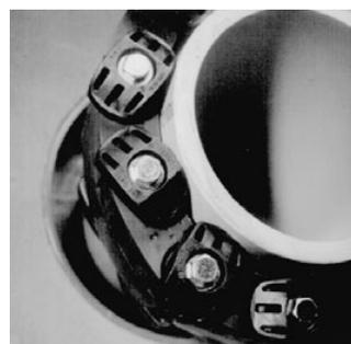
**Permur® Ringraumdichtung Link-Seal® Montage –**
