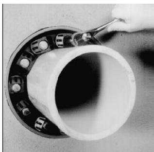
**5.** Beginnen Sie nun auf 12 Uhr Position die Schrauben im Uhrzeigersinn anzuziehen. Anziehen nur mit der Hand, nicht mit Maschinenschraubern.
