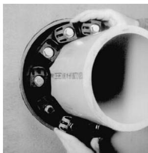
**4.** Schieben Sie den Ring in den Zwischenraum. Die Schraubköpfe sollen auch nach der Montage zugänglich sein. Bei Ketten mit größeren Dichtelementen schieben Sie zuerst den Ring auf 6 Uhr Position ein und dann auf beiden Seiten bis zur 12 Uhr Position.
