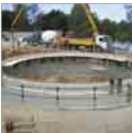
Abwasserbehälter Brisbane (AU), 2007
