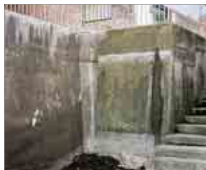
Beanspruchung durch die Verwendung von Trennmitteln (Algenbildung)
