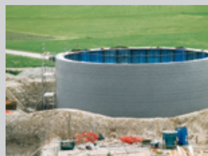
Ocelové bednění s napnutým Zemdrain®em
