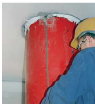
Einpressen des Mörtels von unten zur statischen Stabilisierung und optischen Aufwertung der Säule
