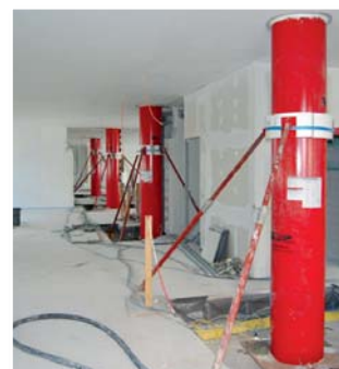
Einpressen des Mörtels von unten zur statischen Stabilisierung und optischen Aufwertung der Säule
