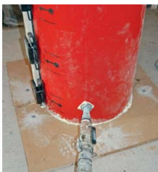
Einpressen des Mörtels von unten zur statischen Stabilisierung und optischen Aufwertung der Säule
