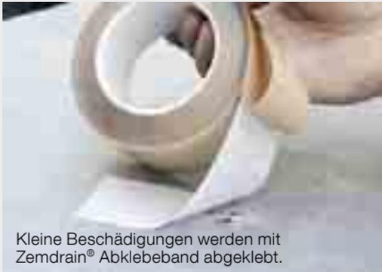
Kleine Beschädigungen werden mit Zemdrain® Abklebeband abgeklebt.
