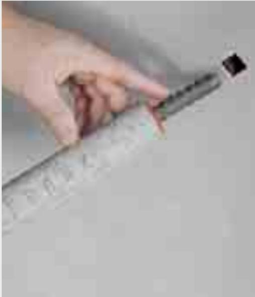
Die Löcher für die Schalungsanker sollten erst dann bearbeitet werden, wenn Zedrain® endgültig auf der Schalung befestigt ist.
