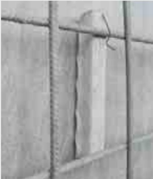
Um sichtbare Abdrücke, z. B. durch Abstandhalter, auf dem Beton zu reduzieren, sollte der maximale Druck auf Zemdrain® nicht zu groß sein (nicht mehr als  $200 \text{ N/cm}^2$ ).
