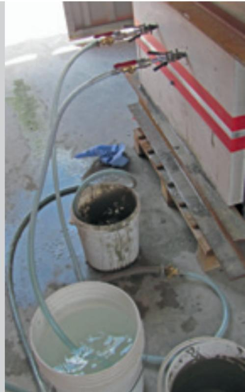
Nach Abschluss der Schlauchreinigung können die Verschlussstücke an beiden Nagelpackern (Entlüftungsschlüuchen) entfernt werden.
