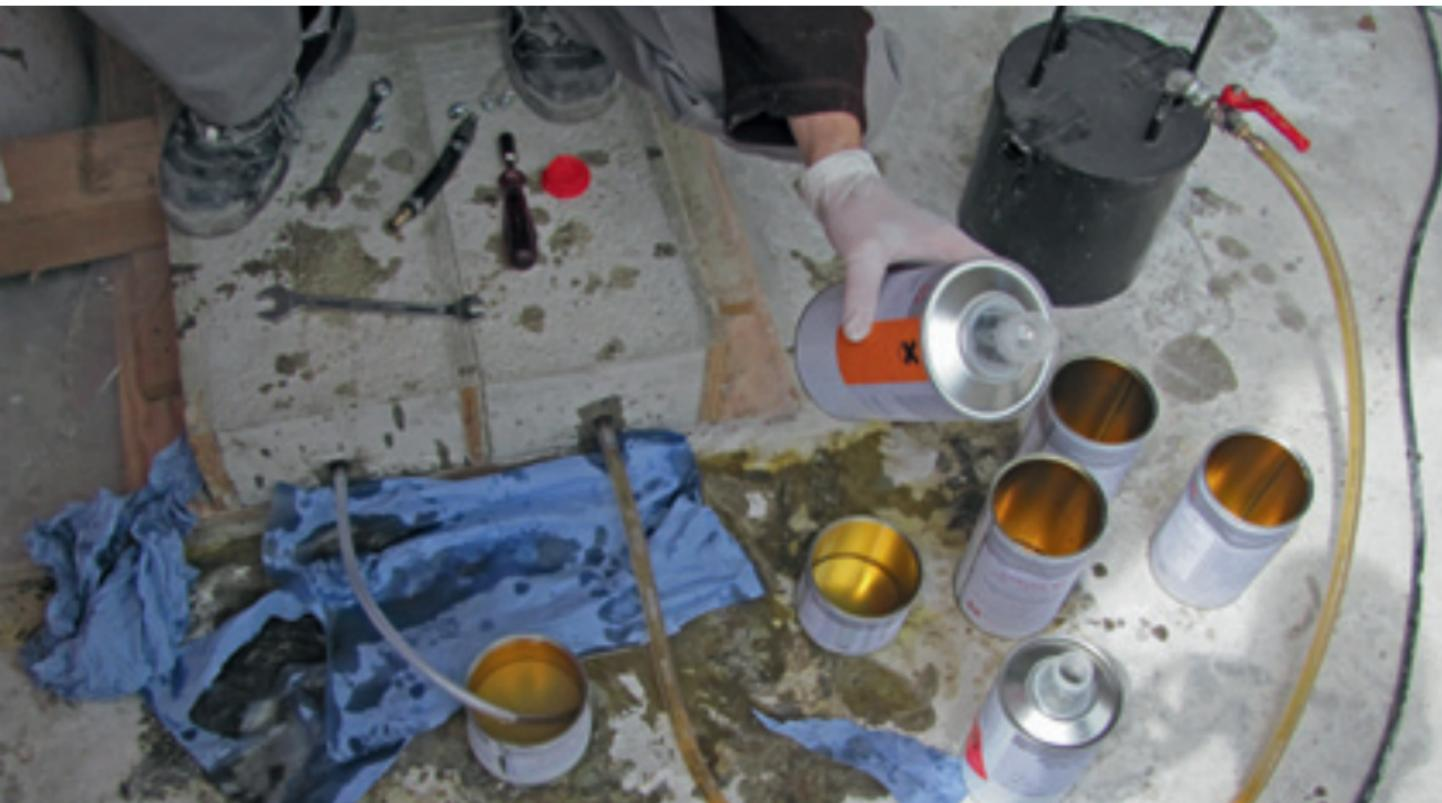
Nach Abschluss der Schlauchreinigung können die Anschlussstücke an beiden Nagelpackern (Entlüftungsschläuchen) entfernt werden.
