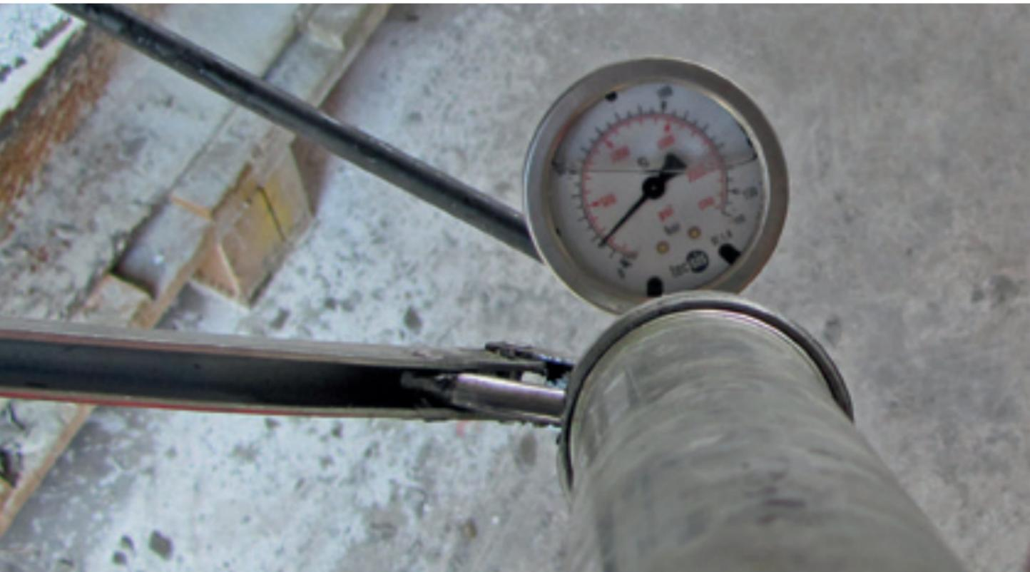
Zur guten Füllung der Fuge, innerhalb der Verarbeitungszeit des Injektionsgutes ein- besser zweimal nachverpressen.
