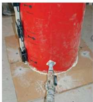
Vtlačování malty od spodu pro statickou stabilizaci a zlepšení vzhledu stávajícího sloupu
