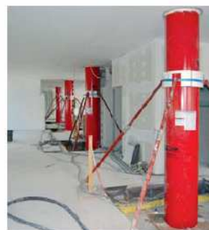
Vtlačování malty od spodu pro statickou stabilizaci a zlepšení vzhledu stávajícího sloupu
