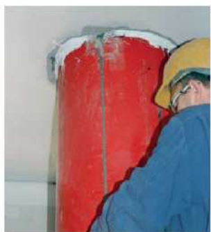
Vtlačování malty od spodu pro statickou stabilizaci a zlepšení vzhledu stávajícího sloupu
