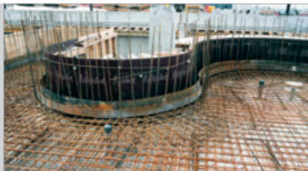
Dílensky provedená skružení.
