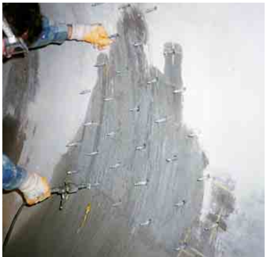
Rasterinjektion mit Schraubpackern
