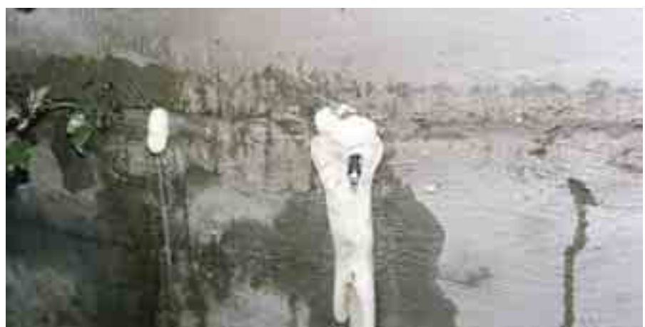
Nach dem Verpressen mit Intectin-Blitz. Der Wasserabfluss wurde in kürzester Zeit gestoppt.
