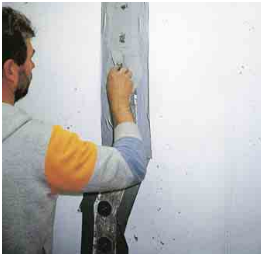
Klebepacker im Einsatz: Verdämmen des Risses
