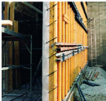
**c)** Upínací háky by se měly podél bočního bednění umísťovat v odstupu ca. 25 až 30 cm. U velmi vysokých bednění by se měl volit rozestup menší. Přitom je nutno dbát na to, aby byl Zemdrain® Classic tažen ručně s velkým napětím přes hranu bednění a aby upínací háky byly zároveň taženy pod úhlem ca. 30° až 45° šikmo nahoru. Začínat vždy zdola a střídavě vkládat háky vpravo a vlevo.
