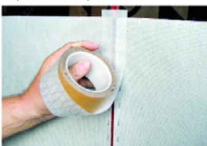
■ sraz dilců bednění utěsnit přelepením krycí páskou s "Zemdrainovým" povrchem
