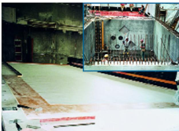
▲ výroba prefabrikátů pro třívrstvé (sendvičové) stěny nádrže na vodu
