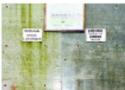
**Problém:** V dutinkách, ve velkých kapilárních pórech a ve vadných místech v povrchu betonu se mohou ve velkých množstvích uhnízdit mikroorganismy. Karbonatizovaný povrch betonu přispívá k růstu bakterií zrovna tak jako zbytky moderních, biologicky odbouratelných odbedňovacích prostředků.
