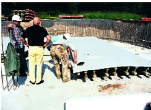
▲ potažení nosníkového bednění Zemdrainem® MD
