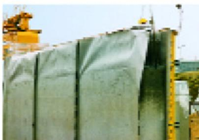
**Problém:** Rychlé unikání vody z čerstvého, nevyzrálého betonu do okolí negativně ovlivňuje hydrataci. To vede ke snížené kvalitě betonu a k vysychání jeho povrchu.
