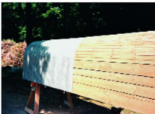
▲ potažení obloukové bednici plochy (ramenat) - spáry mezi prkny jsou překryty Zemdrainem®.
