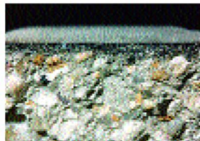
**Problém:** Působením vibrační energie vibrátoru dochází k vytlačování vzduchu a vody k pláště bednění. To způsobuje při použití normálního bednění vznik povrchové betonové vrstvy se zvýšenou hodnotou vodního součinitele v/c.
