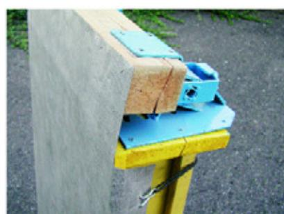
**a)** Šířka role Zemdrainu® Classic by se měla zvolit tak, aby na obou stranách bednicího pravu zůstaly ca. 20 cm přesahy na napnutí. Potom lze materiál rozbalit, přízpnout na správnou délku vč. dostatečných přidavků nahoře a záložky dole a nechat cca 10 minut na plocho relaxovat. Vyrovnat fólii podélně ve středu a upevnit
