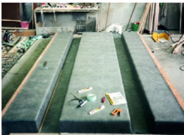
▲ bednění prefabrikátu trámového stropu 2,4 x 8 m potažené Zemdrainem®
