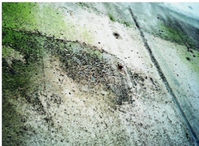
▲ Problémy nízké kvality povrchu betonu se ještě prohlubují působením extrémních nebo silně kolísajících teplot a vlhkosti.
