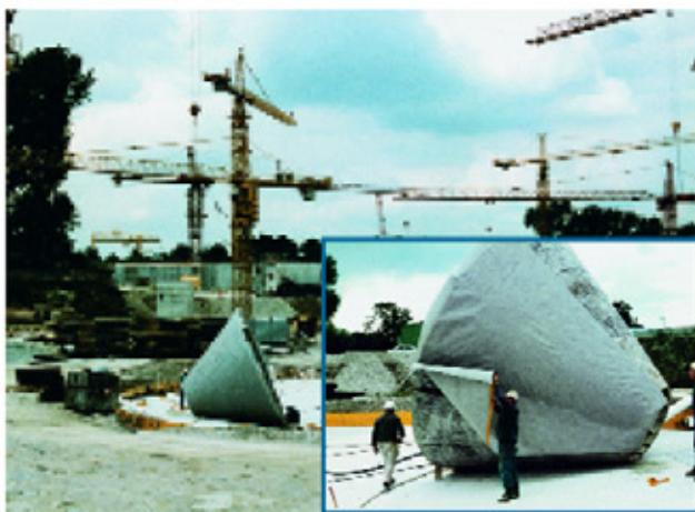
▲ potahení ocelového bednění pro kuželovitý odtok čistící nádrže
