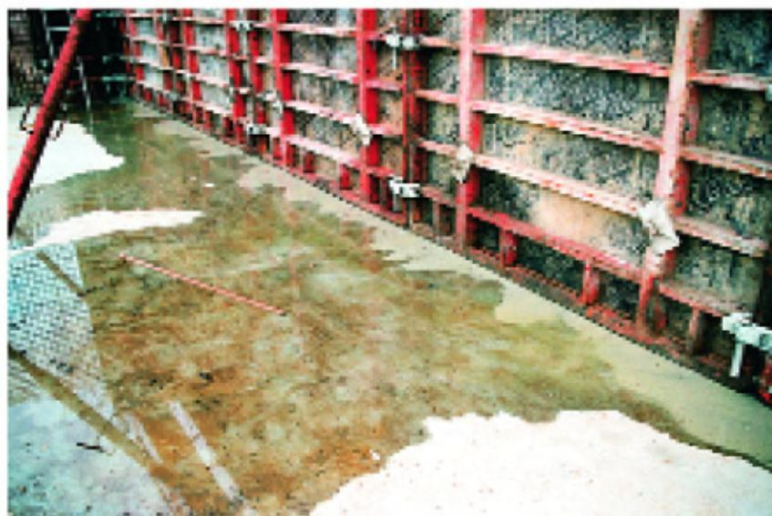
▲ Přebytečná voda profiltrovaná Zemdrainem® se odvádí bedněním ven.
