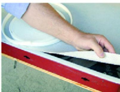
■ okraj fólie při hraně bednění podložit přilepenou pěnovou páskou pro těsnění spár
