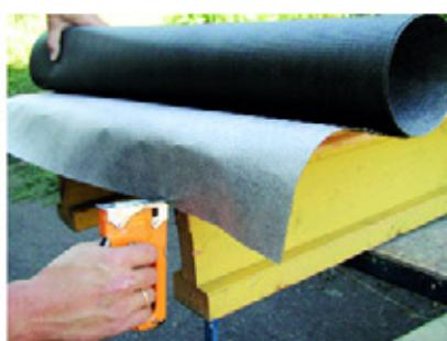
Dbejte prosím na to, aby byl bednící pás obrácen černou stranou k bednění a šedou k betonu.
