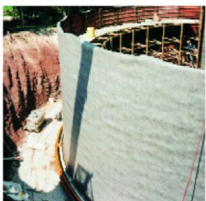
▲ vnitřní bednění nádrže na průsakovou vodu s napnutým Zemdrainem®
