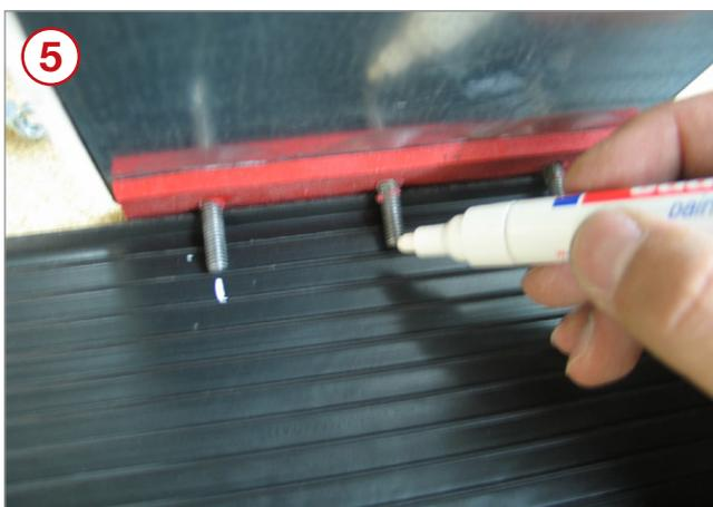
Positionierung des Dehnfugenbandanschlusses am Dehnfugenband markieren und Löcher anzeichnen.
