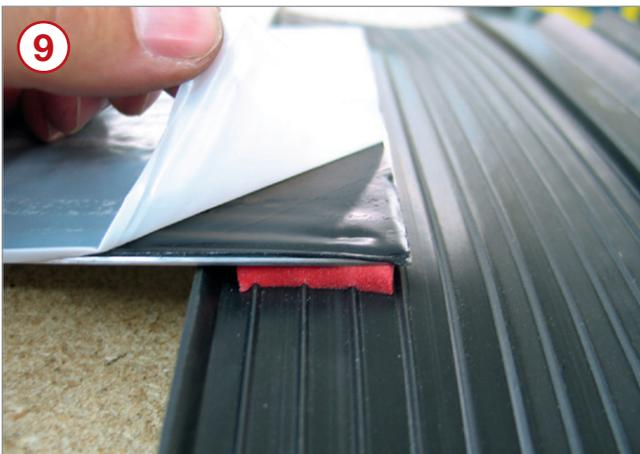
Abdeckfolie der Spezialbeschichtung abziehen und Fugenbandanschluss mit dem Fradiflex Fugenblech zusammendrücken.
