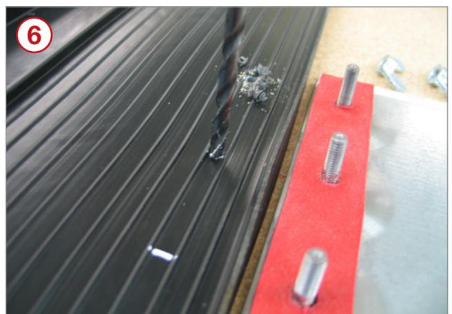
Löcher im Dehnfugenband mit Bohrmaschine und Bohrer DN 6 mm herstellen.
