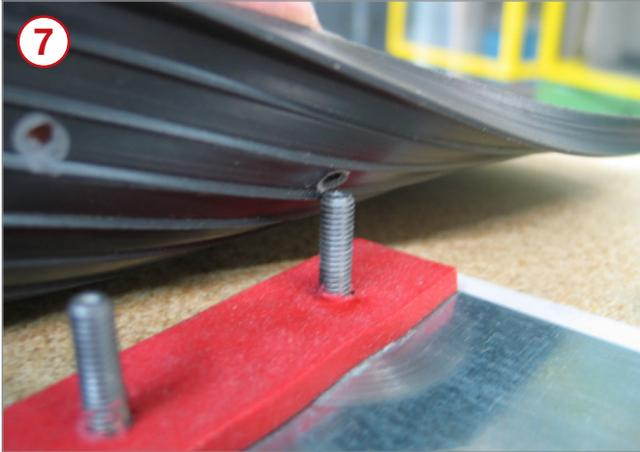
Fugenbandanschluss mit Beschichtung nach außen und Quellband (rot) zum Dehnfugenband hin ausrichten. Die Gewindebolzen durch das Dehnfugenband schieben.
