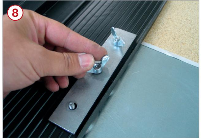
Die Druckplatte innenseitig auf die Gewindebolzen schieben und mit den Flügelmuttern festziehen.
