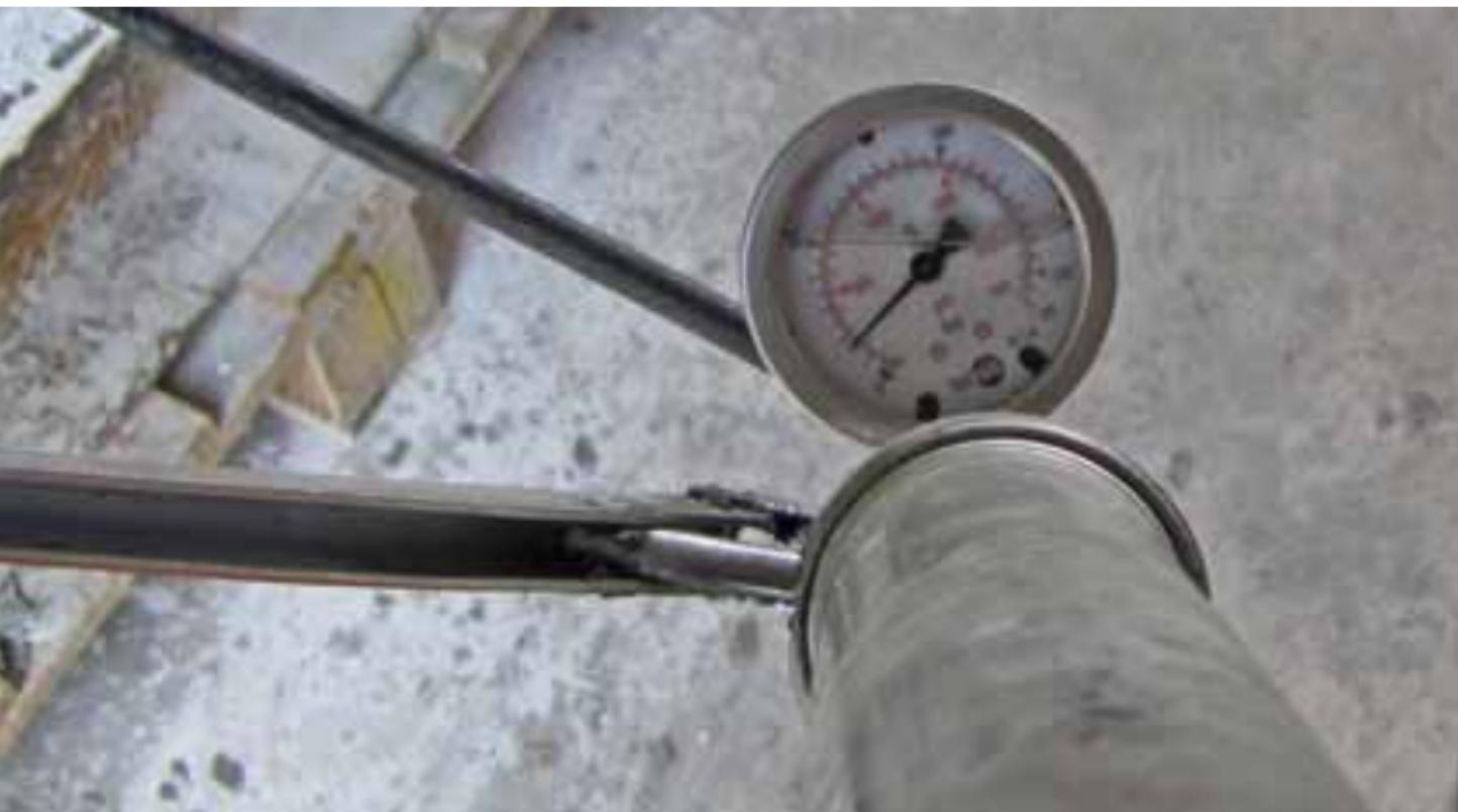
Zur guten Füllung der Fuge, innerhalb der Verarbeitungszeit des Injektionsgutes einmal, besser zweimal nachverpressen. Harzaustritt entlang der Arbeitsfuge ist für eine funktionsfähige Abdichtung **nicht** zwingend erforderlich.
