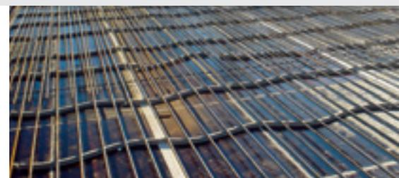
**Bei dünnen Tragstäben ist die Durchbiegung beim Betoniervorgang zu beachten.
