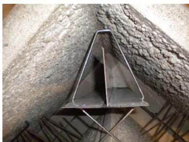
Eine weitere Befestigung ist durch die Eigenstabilität der Bleche nicht erforderlich. Die Fixierbügel können noch während des Betoniervorgangs entfernt werden und mehrfach wieder eingesetzt werden.
